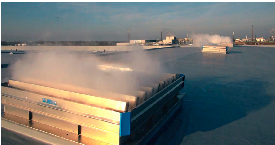
Overdrukkrooster op het dak (© Federatie Veilig Nederland)
